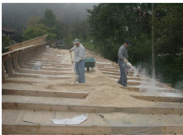
Slika: Prikaz toplotne izolacije strehe na hlevu z uporabo suhe žagovine (Foto Wiedmann)
